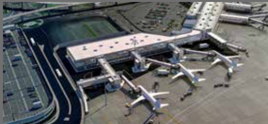
L'extension du hall I - OLW EHI , Aéroport Orly Ouest, France, Groupe ADP
