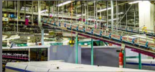
La mise en sûreté de Roissy Hub , plate-forme logistique aéroportuaire stratégique de La Poste. Aéroport Roissy Charles de Gaulle, France.
